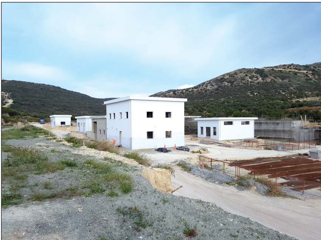
Γενική Άποψη του Σταθμού Κατά το Στάδιο της Κατασκευής του
