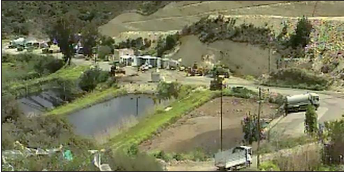
Υφιστάμενες χωμάτινες δεξαμενές διάθεσης λυμάτων στην περιοχή Βατί
