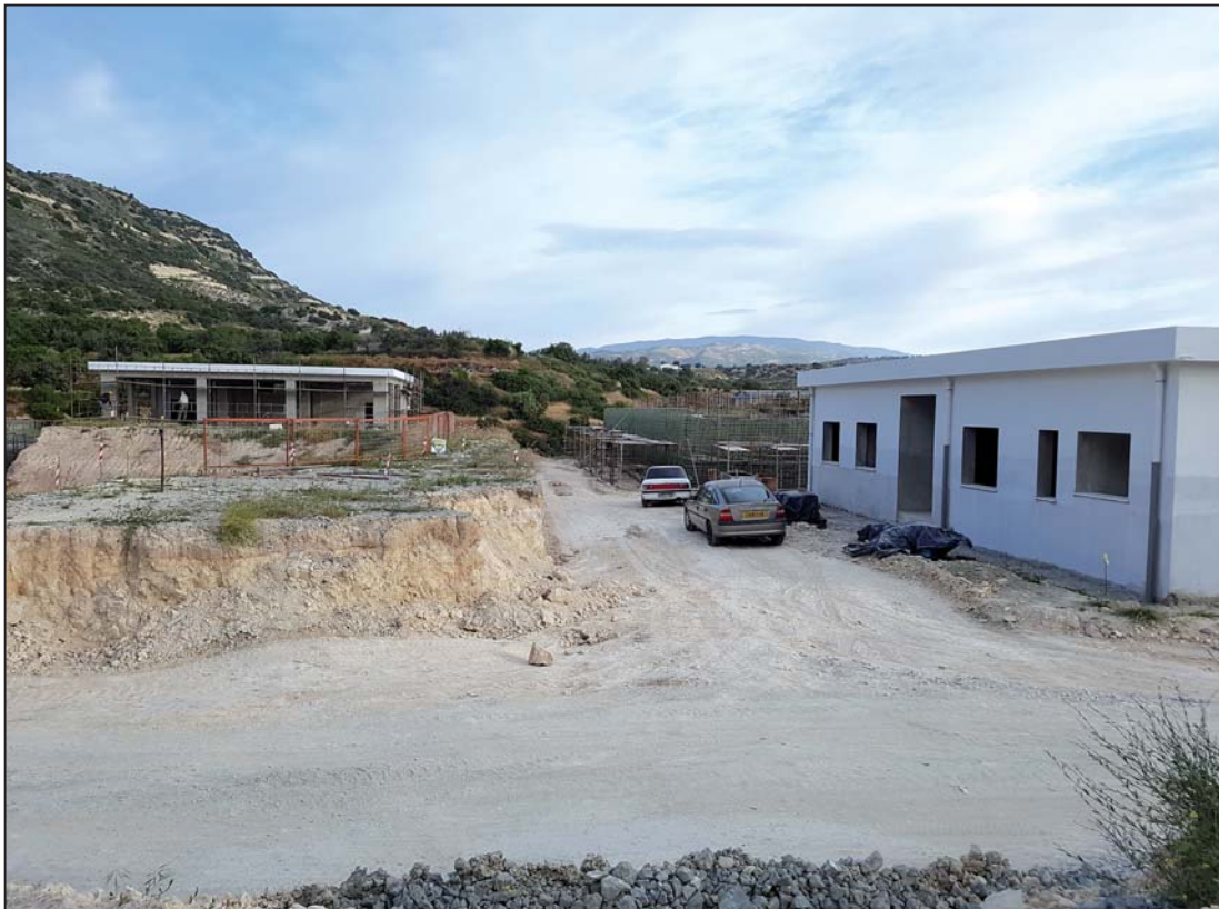
Κατασκευή κτηρίου διοίκησης, Μονάδας Αφυδάτωσης Λάσσης και Συνεργείου του Σταθμού
