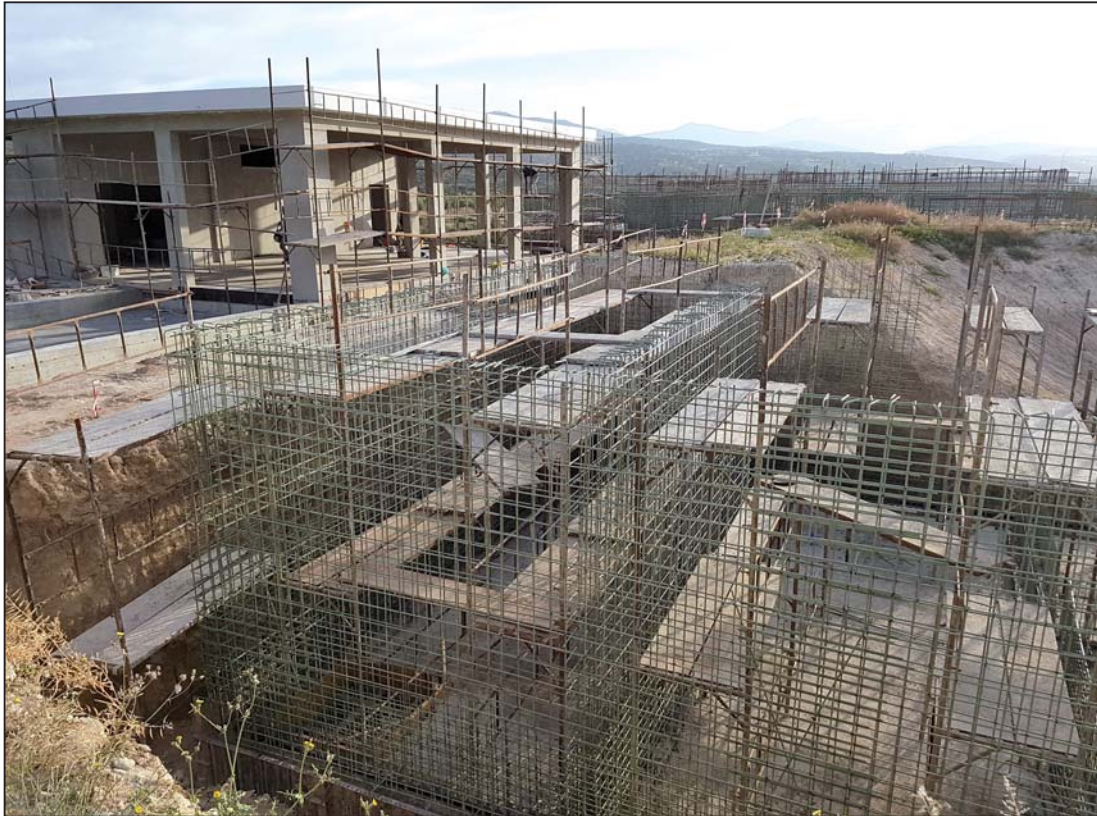
Κατασκευή Μονάδας Προεπεξεργασίας
