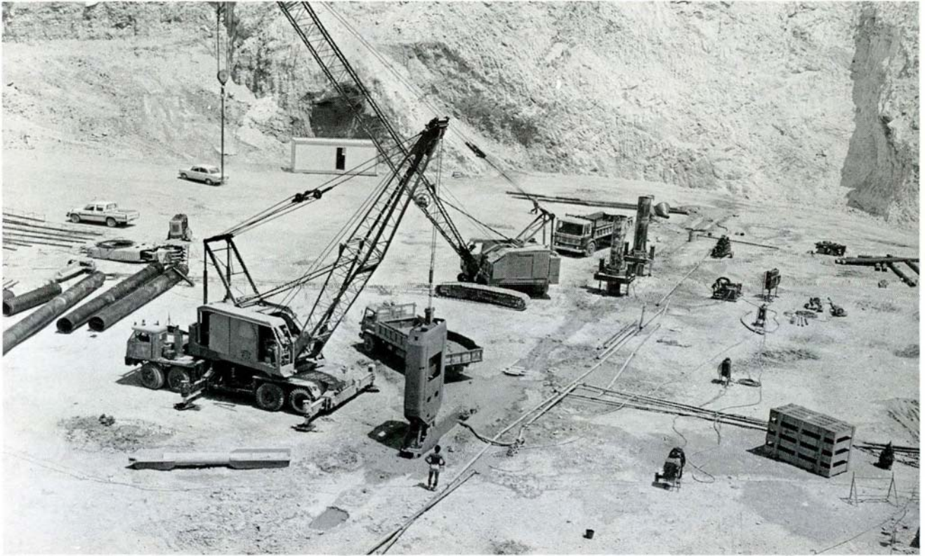
Evretou dam. Diaphragm wall excavation. WDD Photo E50-7. (27.7.84)
