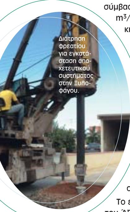
Διάτροπη φρεατίου για εγκατάσταση αποχετευτικού συστήματος στην Ξυλοφάγου.
