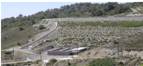
Φωτ 1: Άποψη Σταθμού Επεξεργασίας Λυμάτων και δεξαμενής Αποθήκευσης Κυτπερούντας
