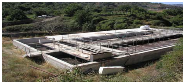
Φωτ 2: Σταθμός Επεξεργασίας Λυμάτων Αγρού
