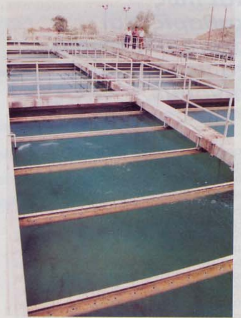
Η λάσπη του νερού, με προσθήκη αργιλίου κατακάθεται στον πυθμένα.
