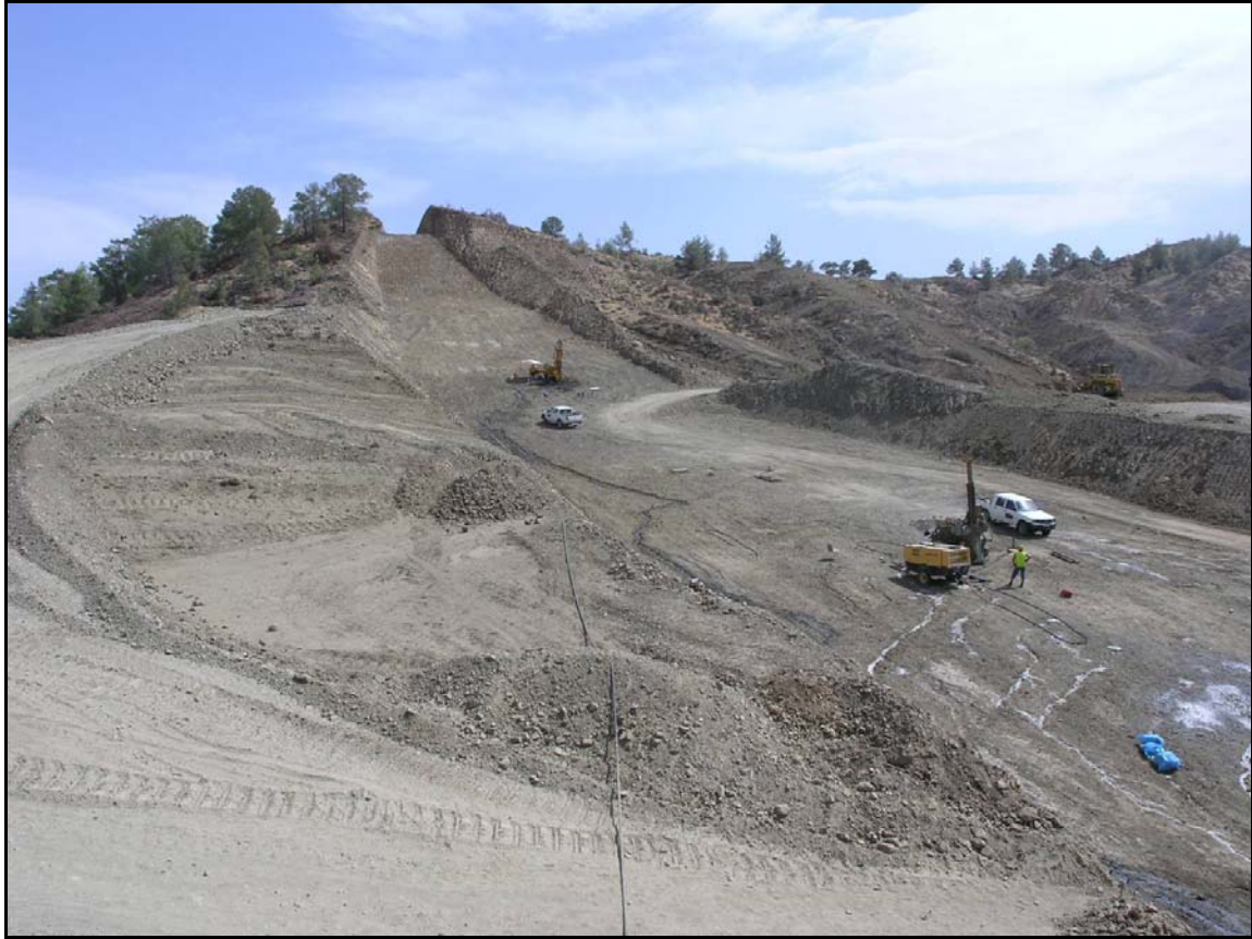
Φωτογραφία 3: Εργασίες στεγάνωσης με εκτέλεση τσιμεντενέσεων κατά μήκος της επιφάνειας θεμελίωσης
