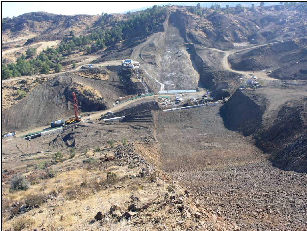
Φωτογραφία 1: Γενική εικόνα των εργασιών, όπου δίνεται η εκσκαφή έως το επίπεδο θεμελίωσης του φράγματος
