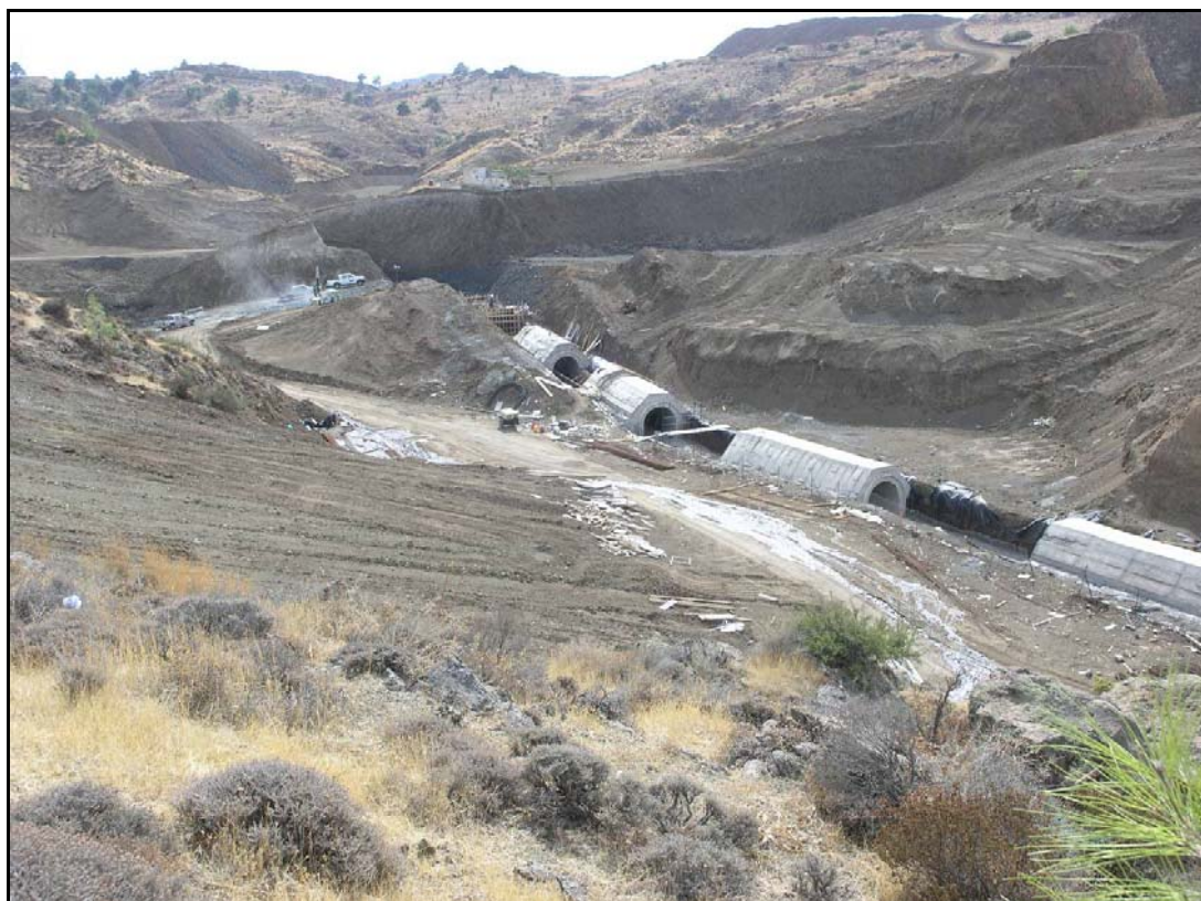
Φωτογραφία 2: Κατασκευή του έργου υδροληψίας και εκκένωσης
