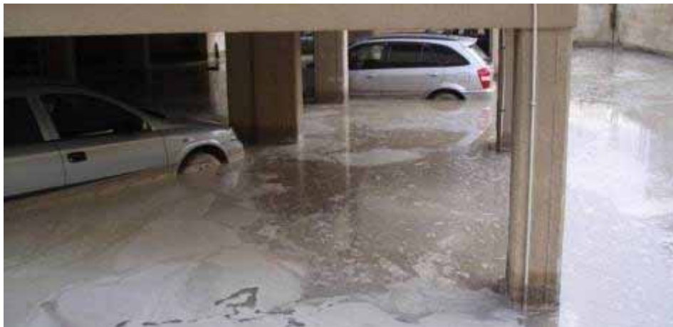
Σχήμα 1-5. Πλημμύρα σε υπόγειο
