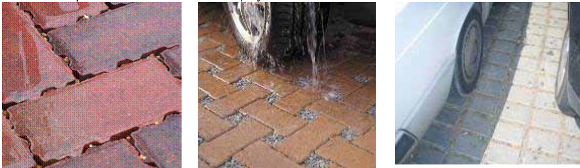
Σχήμα 3-1. Κυβόλιθοι - διαπερατά υπαίθρια δάπεδα
