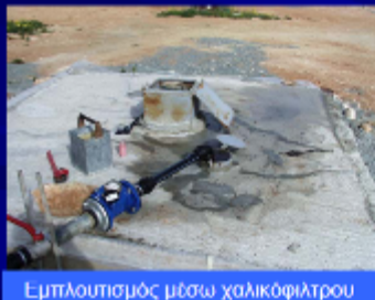
Σχήμα 4-6 Εμπλουτισμός Υδροφορέα (Παράδειγμα στα Κοκκινοχώρια – Κ. Κωνσταντίνου. Τμ. Γεωλογικής Επισκόπησης)
