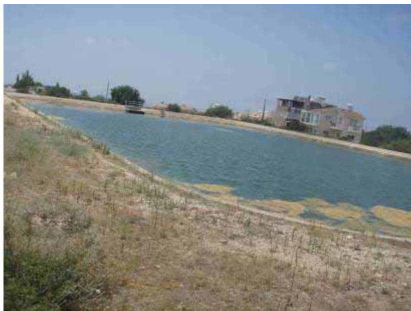
Σχήμα 12-3 Ορθογωνική Δεξαμενή ΤΑΥ- Περιφραγμένος χώρος
