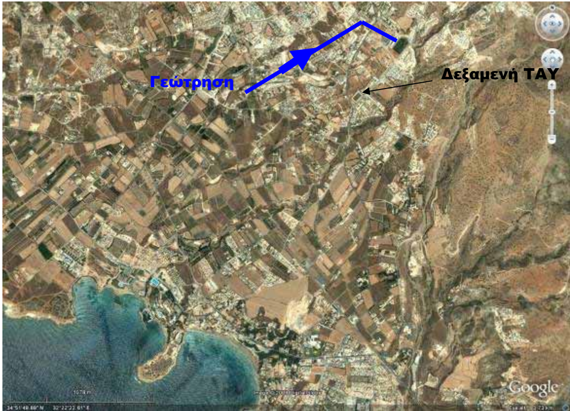
Σχήμα 12-2 Γεωτρήσεις και Χρήση Νερού – Δεξαμενή ΤΑΥ
