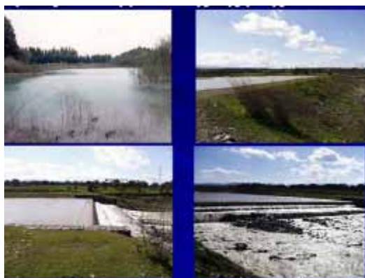
Σχήμα 3-2. Λίμνες κατακράτησης (Κ. Κωνσταντίνου (Τμ. Γεωλ. Επισκόπησης))
