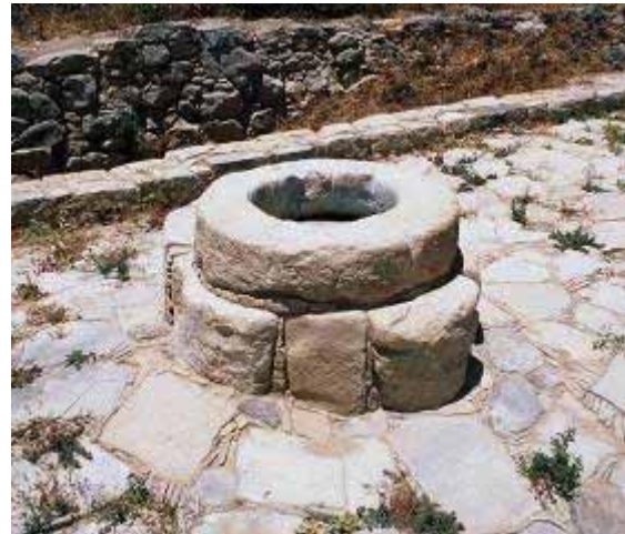
Σχήμα 1-3. Ενετική Στέρνα στο χωριό Απιασιά - Υπόγεια δεξαμενή αποθήκευσης όμβριων υδάτων για της ανάγκες των κατοίκων του χωριού, πέραν των πεντακοσίων χρόνων.
