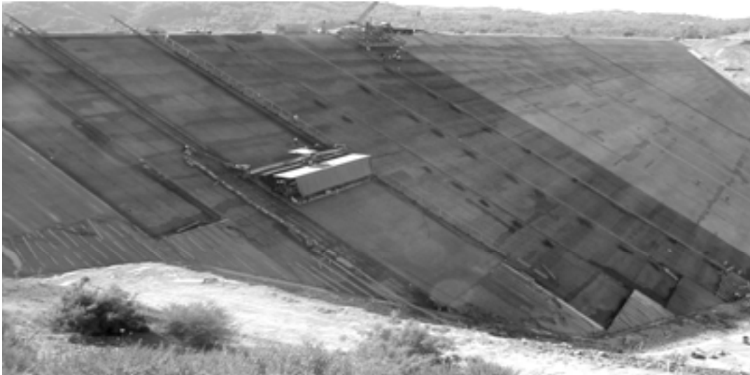
Εικόνα 4. Γενική όψη εργασιών ανάντη πλάκας.
