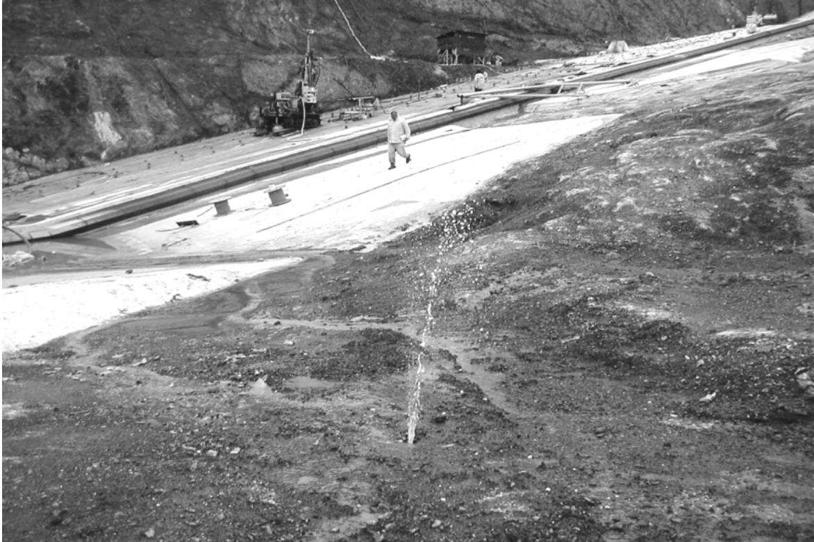
Εικόνα 8. GIN Grouting.
