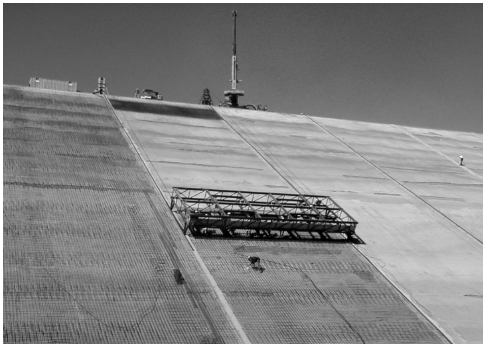
Εικόνα 3. Τοποθέτηση οπλισμού ανάντη πλάκας.
