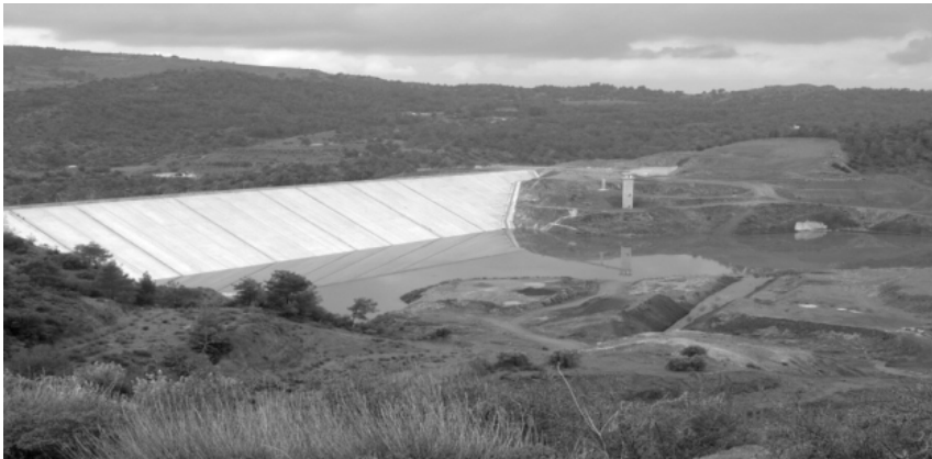
Εκόνα 1. Γενική όψη του Φράγματος.
