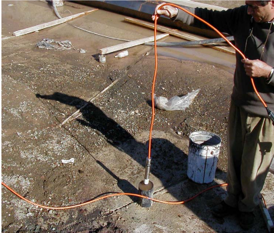
Φωτο.2 Τοποθέτηση ηλεκτρικών πιεσομέτρων.
