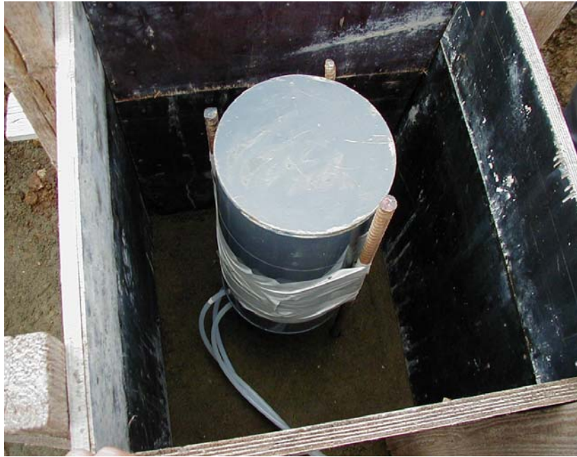
Φωτο. 3 Τοποθέτηση υδραυλικού κλισιόμετρου σε αργιλικό πυρήνα.
